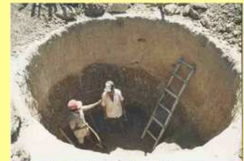
Eine Grube für eine zukünftige Zisterne
